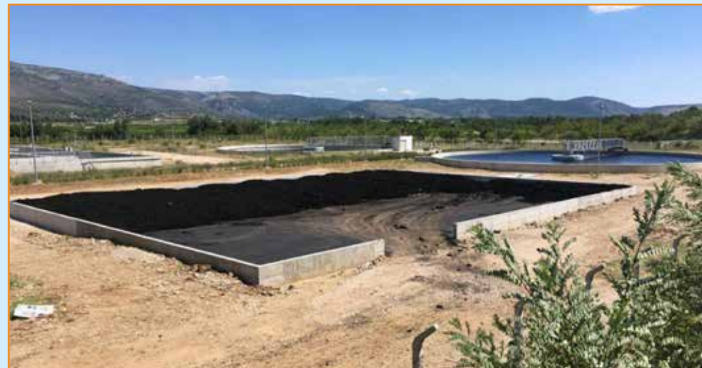
Pročistač u južnom dijelu grada stavljen je u funkciju
