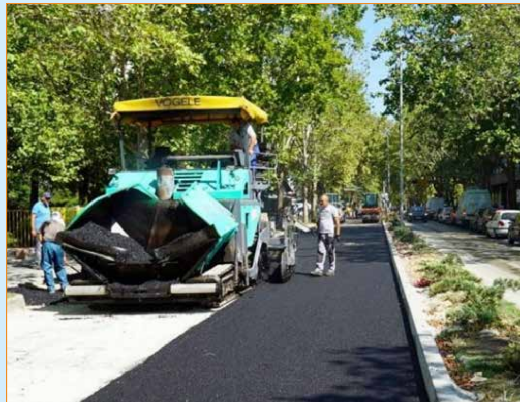
Kompletna rekonstrukcija Ulice kralja Tomislava
