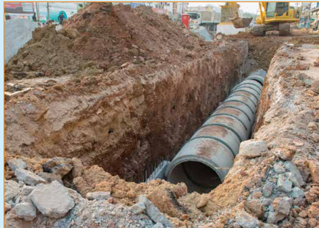
Novi sustav kanalizacije u Opinama čekao se godinama
